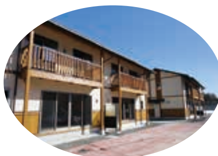
小川3号住宅8世帯（平成25年完成）
