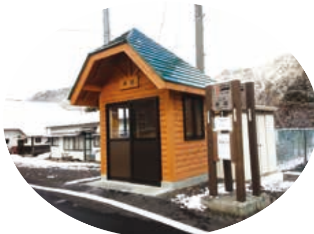
崩越バス停（平成27年完成）
