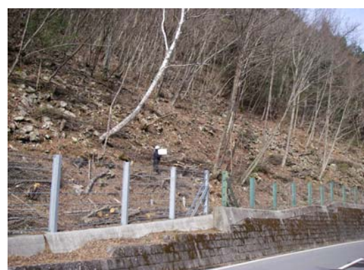
緩衝帯や里山整備を行いました。
