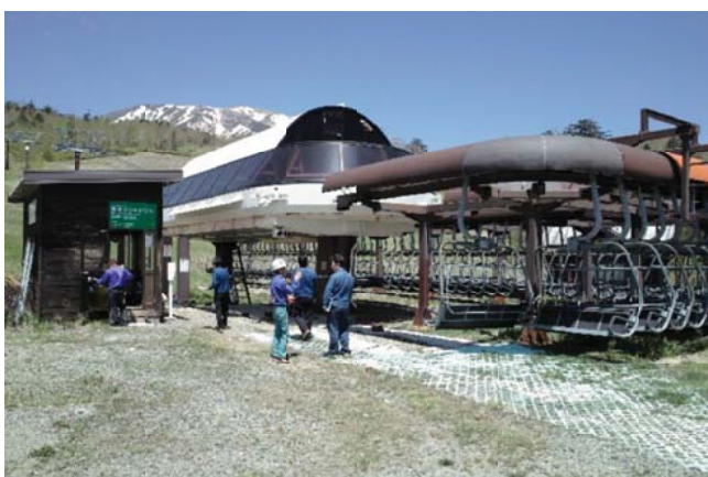
スキー場施設の引継ぎ作業（6月6日：第5クワット）
