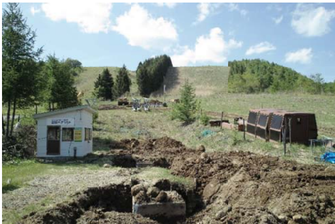
高原ペアリフトの撤去
