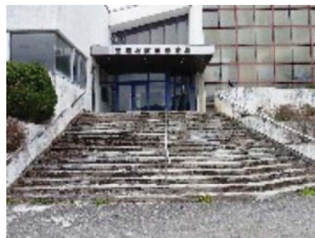
国民体育館入口階段の修繕
