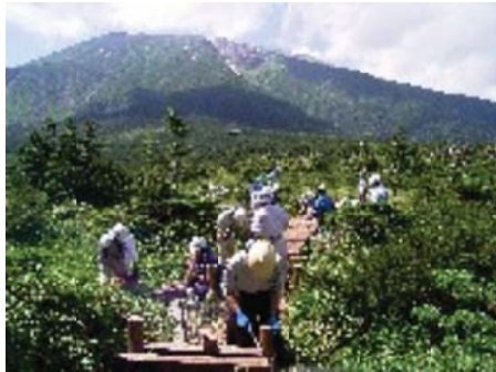
田の原遊歩道整備
