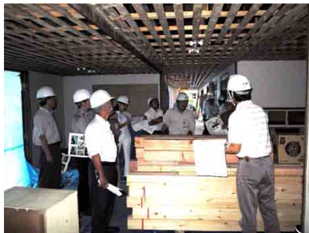
王滝保育園改修工事視察（8月24日）
