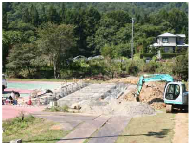
村営住宅建設工事（小川テニスコート）
