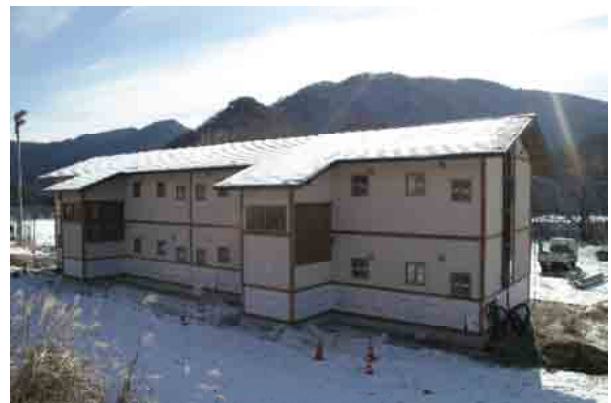
(小川地区に建設中の村営住宅)
