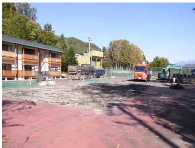
定住促進施設建築現場（小川テニスコート）
