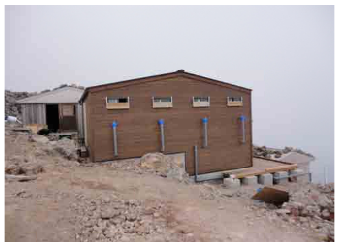
増改築された王滝頂上山荘便所
