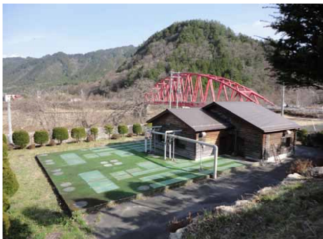
22年が経過する王滝処理場
