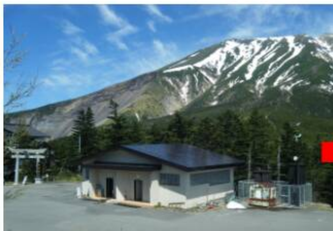
解体前の田の原公衆トイレ
