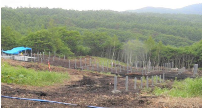
太陽光発電施設の工事が進む高原地区
