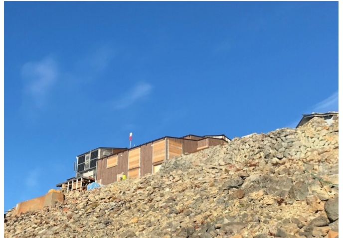
王滝頂上避難施設が完成。来季から供用開始予定
