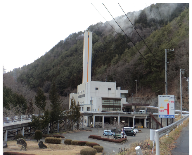
建替えが予定されているクリーンセンター
