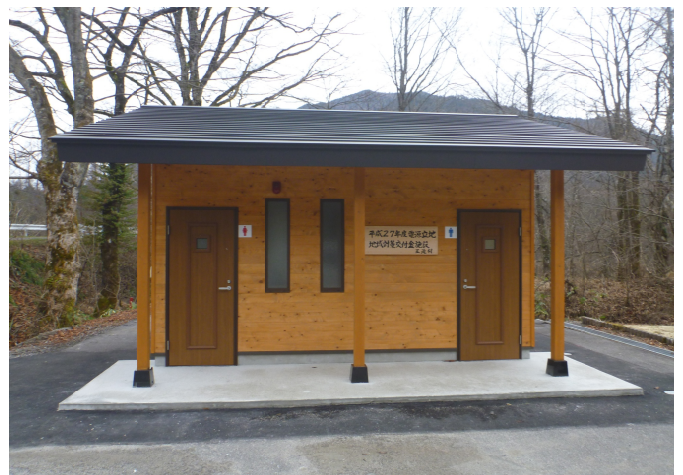
滝越地区に完成した公衆トイレ
