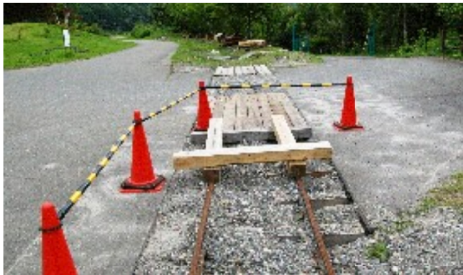
ここから先は只今工事中 （松原スポーツ公園の王滝森林鉄道）
