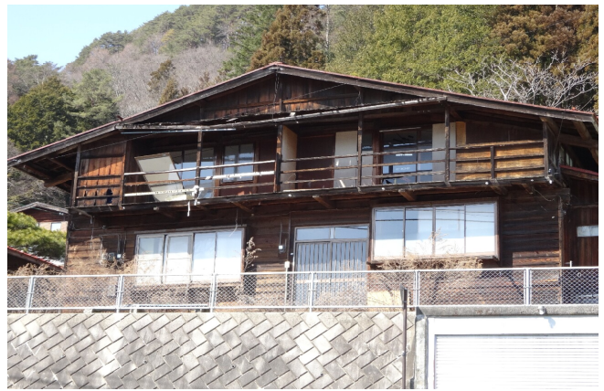
解体が予定されている下条の村営住宅
