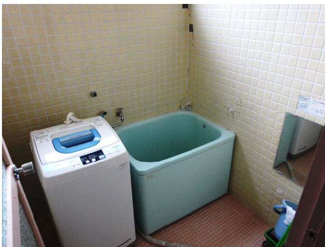
改修される保育園の浴室
