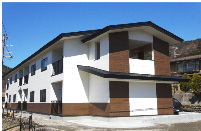
上条区浅原宅下に建設された新村営住宅
