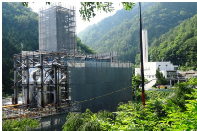
建設中の新焼却炉と現在稼働中の焼却炉（右側）
