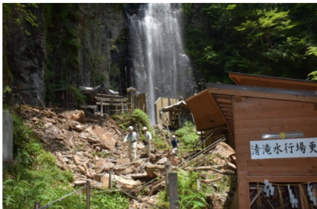
地震で岩が崩落した清滝と破損した木造小屋
