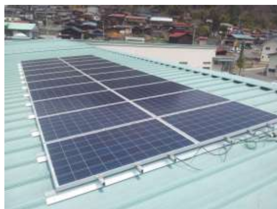
保健センターの屋根に設置された太陽光パネル
